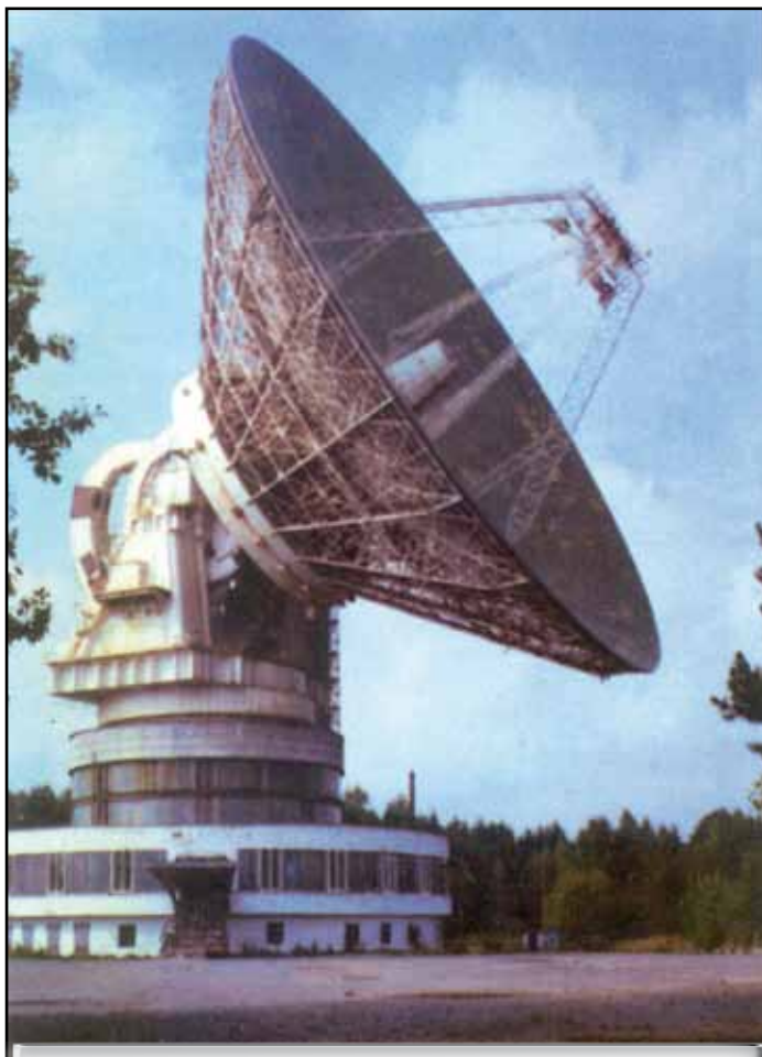
Радиотелескоп РТ-64 с телевизионно-направленной антенной ТНА-1500 для дальней космической связи. Посёлок Медвежье озеро (Подмоскowie). Металлические конструкции для радиотелескопа изготовлены заводом «Электромаш»
