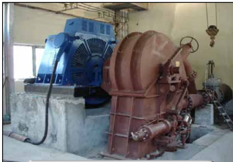
Армения. Гидрогенератор СГ на объекте эксплуатации.
